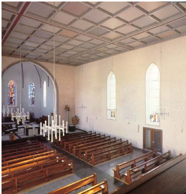
Pfarrkirche Jonschwil, Architekturbüro Felix Schmid AG, Rapperswil
