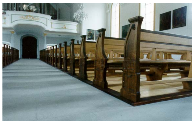
Sitzbankheizung praktisch nicht sichtbar tubes chauffantes sous les bancs, pas visible
