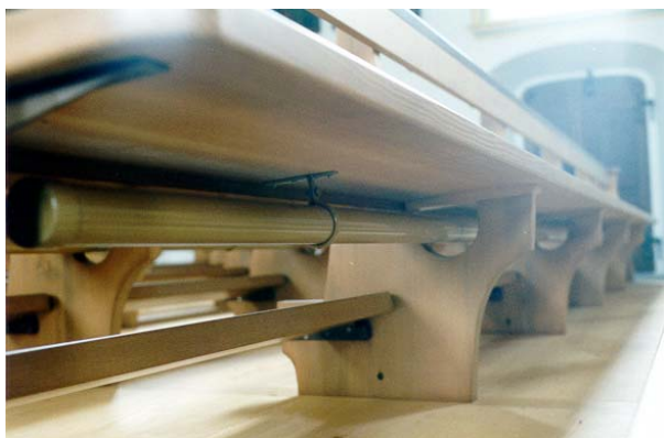
Sitzbankheizung -Bankmontage Montage tubes chauffantes sous les bancs
